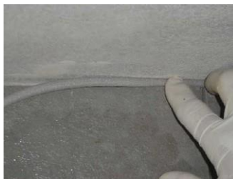
Foto 39: Inserção do limitador de fundo de junta
