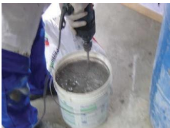
Foto 37: Mistura da Argamassa Colante com a haste helicoidal acoplada na furadeira.
