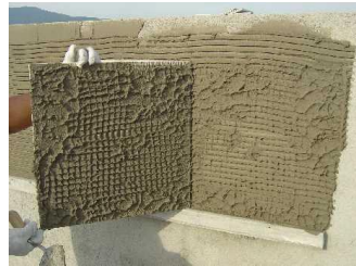
Foto 66: Cordões da argamassa colante não esmagados com dupla colagem
