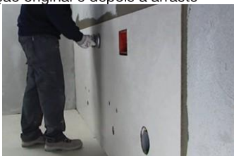
Foto 55: Utilizar ventosas para auxiliar o arraste das peças para o lugar. Nunca utilizar ventosas para o transporte de peças
