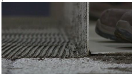
Foto 11: Em duas pessoas, apoie a placa cuidadosamente no chão evitando pancadas e lascamentos.
