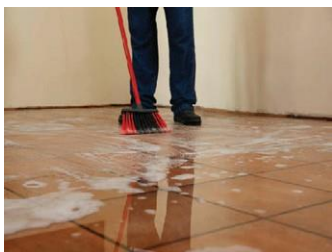
Foto 22: Esfregue bem o chão e remova toda a cera e sujeira.
