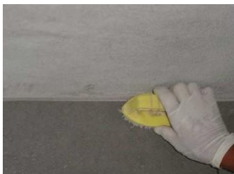
Foto 38: Remoção da argamassa colante do interior da junta de dessolidarização
