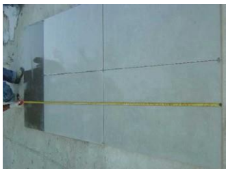
Foto 45: Placas espalhadas com espaçadores para verificação da localização dos cortes
