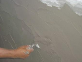
Foto 28: Em paredes, espalhar a argamassa sobre a base.
