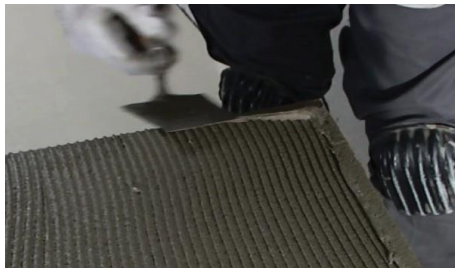
Foto 52: Aplicar reforço de argamassa em todo o perímetro da placa
