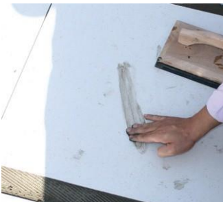
Foto 58: Normalmente as trincas apenas aparecerão quando a superfície da placa for suja
