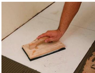
Foto 54: Utilize a desempenadeira ao invés do martelo de borracha
