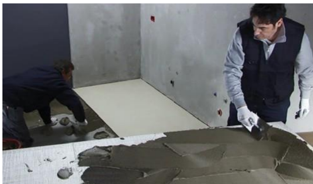
Foto 50: Para placas de 300x100, é obrigatório o trabalho em conjunto de dois ou mais assentadores
