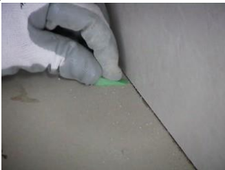
Foto 41: Posicionamento dos calços para início do assentamento
