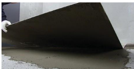
Foto 12: SOZINHA, a pessoa volta a inclinar a placa para a horizontal pelo centro da peça.
