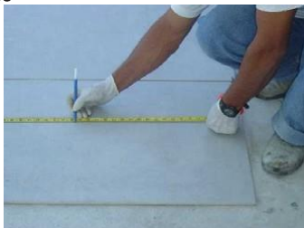
Foto 47: Marcação da localização dos cortes nas placas
