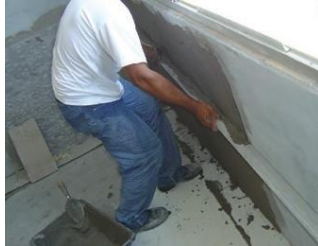
Foto 29: Procedimento aplicado também em paredes.
