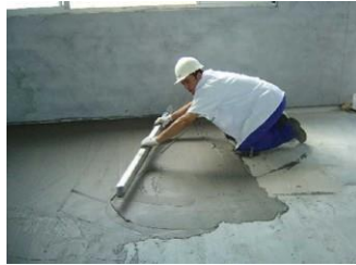
Foto 27: Profissional regularizando a argamassa com régua metálica.
