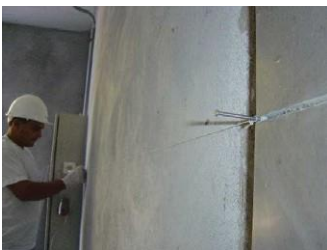
Foto 43: Linha de Nylon sendo esticada (paredes)
