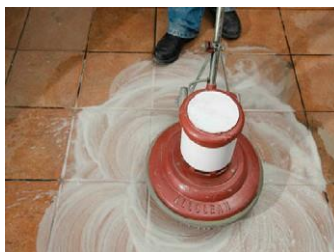
Foto 23: Foto 25: Opção de uso de enceradeira para melhores resultados
