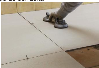
Foto 56: Utilizar ventosas para auxiliar o arraste das peças para o lugar. Nunca utilizar ventosas para o transporte de peças
