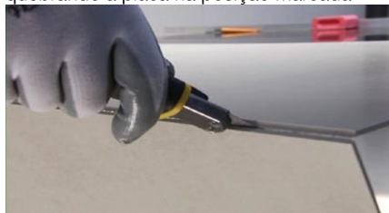
Foto 76: Passe um estilete comum para cortar a tela
