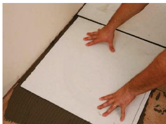
Foto 53: Coloque a peça 5 cm distante de sua posição original e depois a arraste
