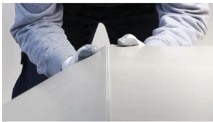
Foto 75: Com as mãos, faça uma leve flexão quebrando a placa na posição marcada
