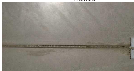
Foto 63: Junta limpa após a remoção da argamassa colante no interior
