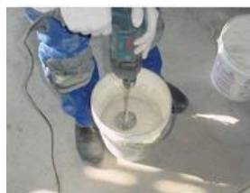
Foto 84: Mistura da argamassa de rejunte com haste helicoidal
