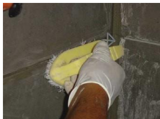
Foto 62: Imediatamente limpar as juntas com escova de cerdas de nylon ou palito de madeira
