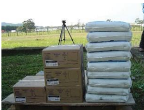
Foto 14: Armazenamento de argamassa colante e rejunte sobre o estrado de madeira.
