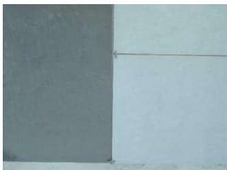
Foto 46: Espaçadores plásticos entre as placas simulando a dimensão real do revestimento assentado
