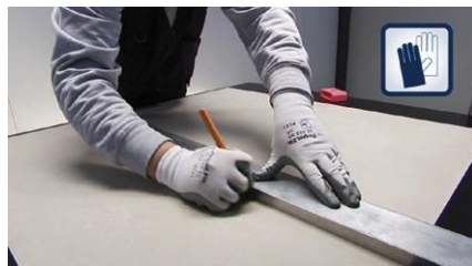
Foto 73: Passe a vídia com firmeza e continuidade, evite parar para ter um acabamento melhor
