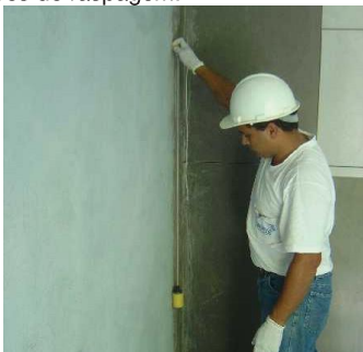
Foto 18: Verificação do prumo das paredes
