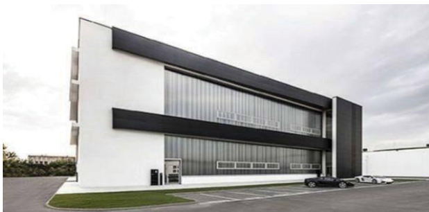
Foto02: Fachada Ventilada Favenk: Lastra instalada na fachada da fábrica da Lamborghini em Sant'Agata Bolognese
