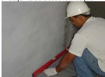
Foto 40: Posicionamento dos calços para início do assentamento
