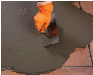
Foto 30: Em sobreposições, espalhe a argamassa na região com problemas.
