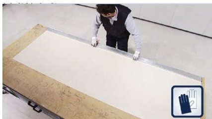
Foto 72: Posicione a régua metálica e a prenda com pelo menos 2 sargentos
