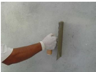
Foto 16: Verificação de dureza da base através de raspagem.
