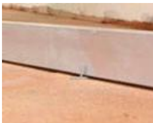
Foto 25: Caso de irregularidade. O Espaçador de 2 mm coube sob a régua metálica
