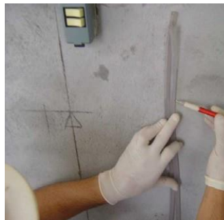
Foto 19: Verificação do nível e caimento do piso
