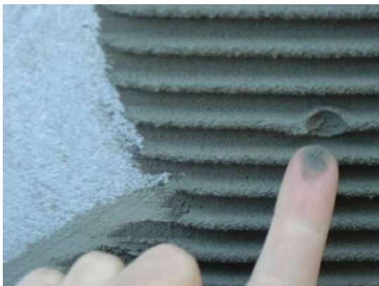
Foto 51: Cordão da argamassa amassado sujou o dedo: tempo em aberto não vencido
