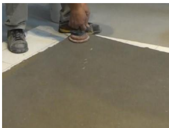
Foto 68: No caso de formatos maiores que 70 cm, utilize ventosa numa das pontas para levantar a peça
