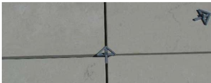
Foto 59: Utilização de espaçadores recuperáveis nas juntas para auxiliar na regularidade das juntas
