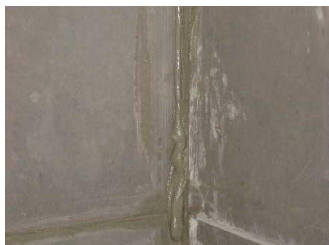
Foto 61: Junta com resíduos de argamassa colante no interior
