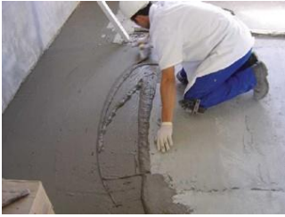
Foto 26: Realização do nivelamento do contrapiso com argamassa colante.
