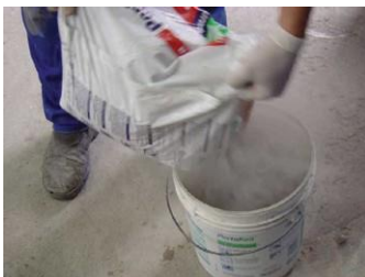
Foto 35: Preparo da Argamassa Colante.
