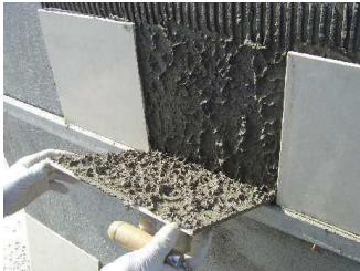
Foto 65: Cordões da argamassa colante completamente esmagados
