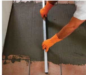
Foto 31: Utilize a régua para regularização.
