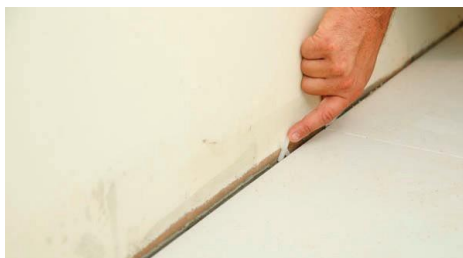
Foto 63: Detalhe da junta de dessolidarização em todo o encontro com as paredes
