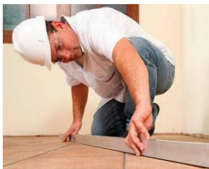
Foto 24: Inspeção de planicidade do piso de base.
