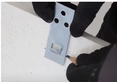
Foto 26: Marcação no verso da placa para realização do corte
