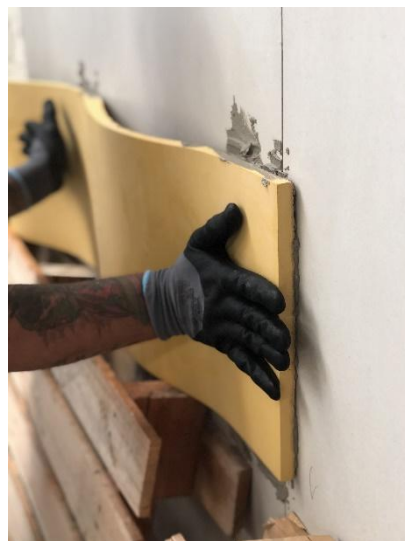
Foto 23: Arraste da placa para romper os cordões de argamassa
