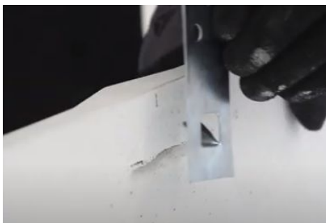
Foto 29: Inserção do insert metálico
