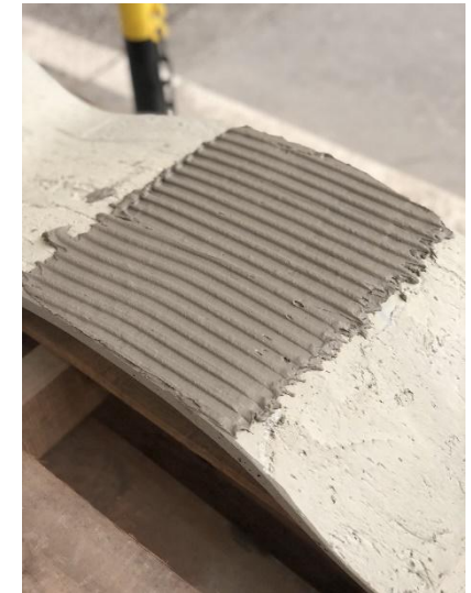
Foto 21: Aplicação de argamassa colante no verso da placa
