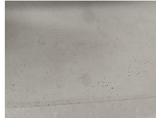
Foto 06: Pequenas bolha aparentes na superfície.
