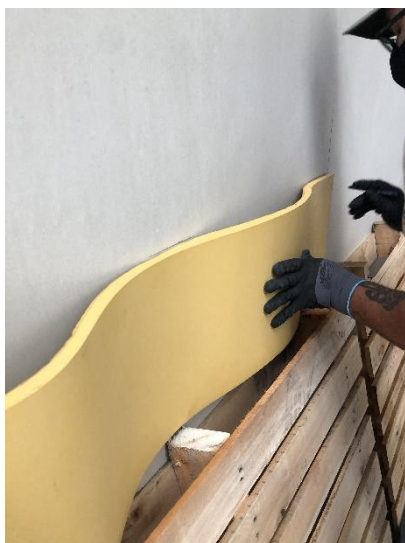
Foto 16: Posicionamento da peça no local exato sem argamassa colante
