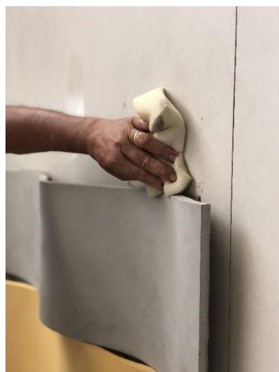
Foto 25: Limpeza logo após o assentamento, com a argamassa fresca
