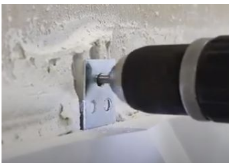
Foto 30: Perfuração do emboço
