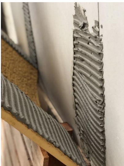
Foto 22: Assentamento da peça com os cordões em paralelo
