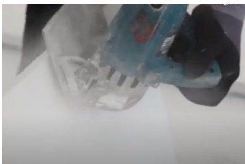
Foto 28: Corte com serra mármore regulada a 45°
