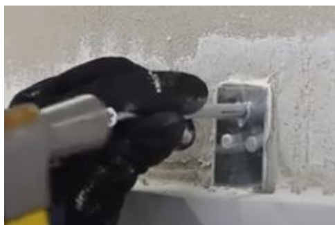
Foto 31: Fixação da bucha prego com martelo
