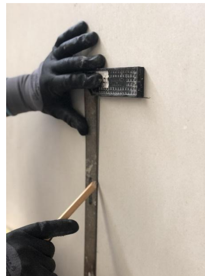
Foto 18: Marcação do local de aplicação da argamassa colante com esquadro
