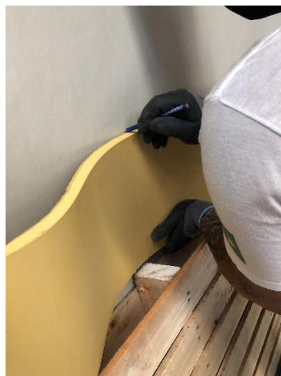
Foto 17: Marcação para posterior aplicação de argamassa colante
