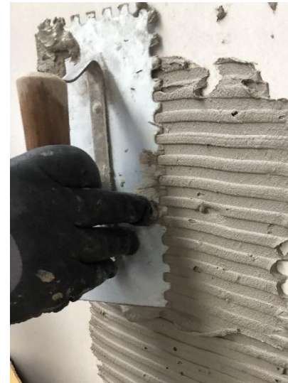
Foto 20: Aplicação de argamassa colante na base de assentamento
