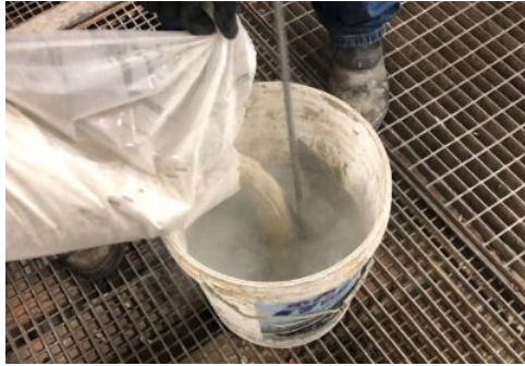
Foto 13: Preparo da argamassa colante | adição do líquido.
