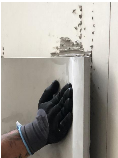
Foto 24: Excesso De argamassa sobre a base de assentamento
