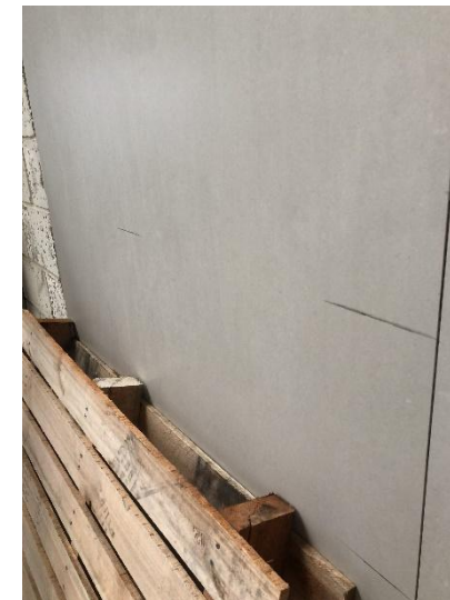
Foto 19: Local marcado para aplicação da argamassa colante
