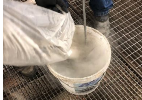
Foto 14: Preparo da argamassa colante | adição do pó.
