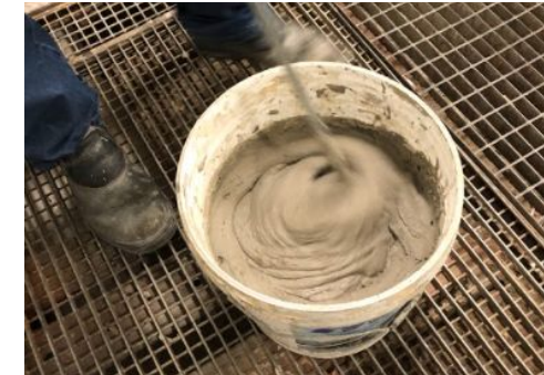
Foto 15: Mistura com haste helicoidal, formando uma pasta homogênea.
