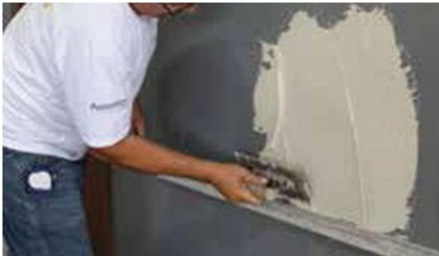
**Foto 21:** Aplicação da argamassa colante na base de assentamento com lado liso da desempenadeira em um ângulo de aproximadamente 30°
