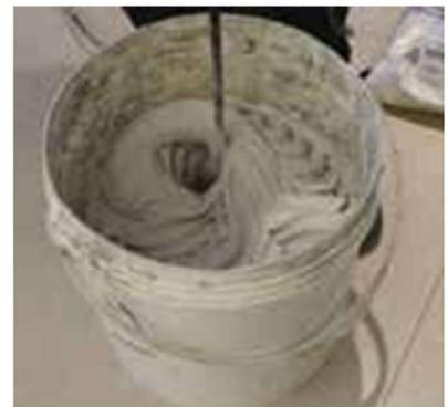
**Foto 17:** Mistura com haste helicoidal, formando uma pasta homogênea
