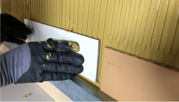
**Foto 26:** Posicionamento da peça cerca de 3cm da localização final e execute o arraste
