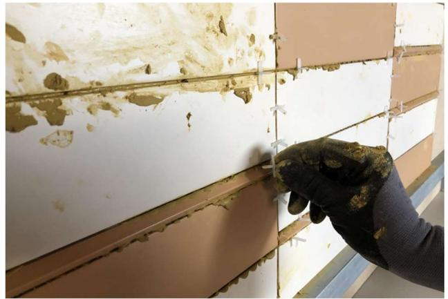
**Foto 29:** Inserir o espaçador de 2mm nas juntas das peças
