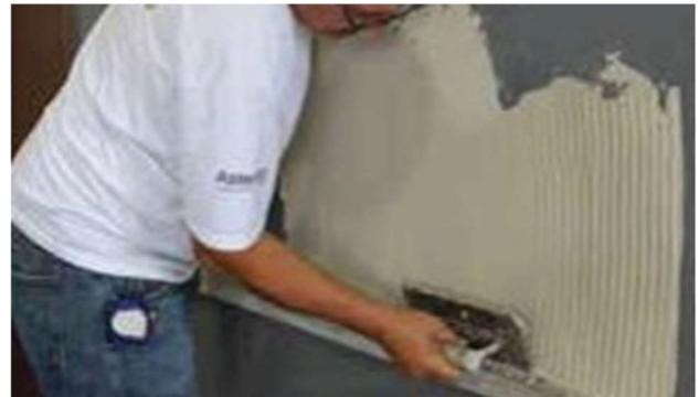
**Foto 22:** Formação dos cordões na argamassa colante com desempenadeira lado dentada formando um ângulo de 60°.
