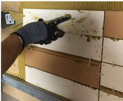
**Foto 30:** Remova a peça encaixando a colher de pedreiro e puxando.
