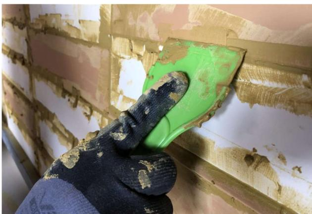
**Foto 33:** Aplicação de argamassa de rejuntamento nas juntas de assentamento com espátula plástica
