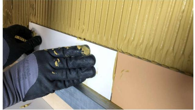
**Foto 27 :** Peças arrastadas até a posição final, esmagando os cordões de argamassa colante, visualização de excesso de argamassa colante nas juntas entre peças
