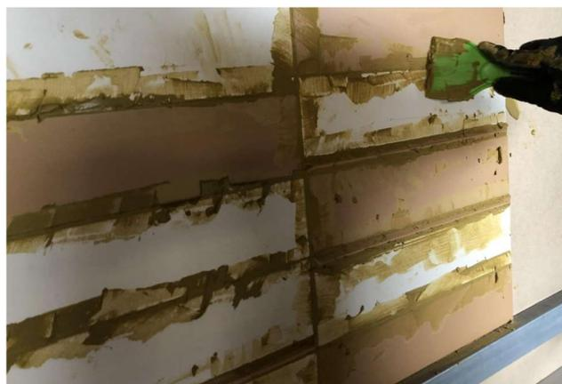
**Foto 34:** Remoção do excesso de argamassa com espátula de plástico
