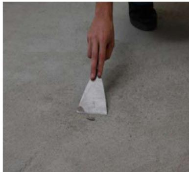
**Foto 11:** Remoção de objetos aderidos com espátula metálica
