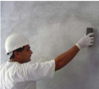
**Foto 10:** Limpeza da parede com escovas de cerdas de nylon ou vassoura no caso de chão.
