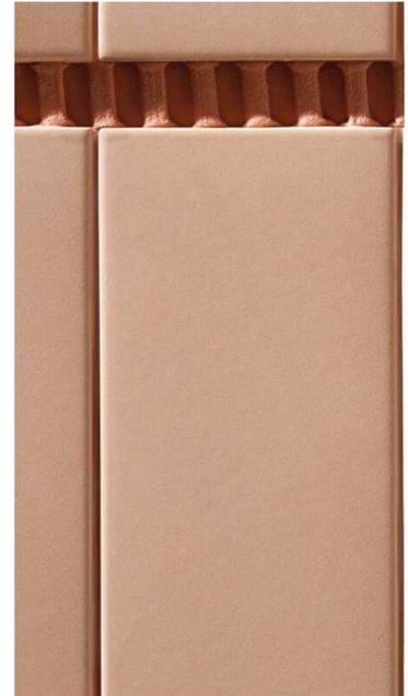
**Foto 41:** Detalhe aproximado do friso executado de argamassa colante com cordões formados entre peças do Terralma Sardenha.
