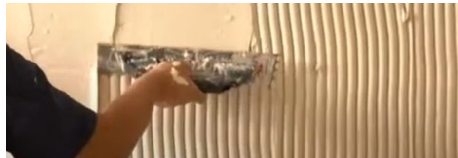
Imagem 28: Abertura de cordões no revestimento cerâmico com lado dentado da desempenadeira.
