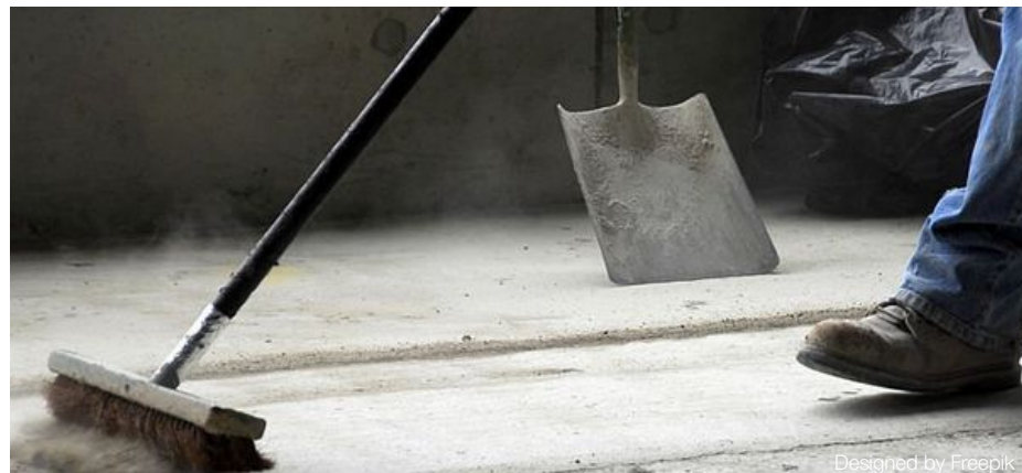
Imagem 22: Limpeza da base que receberá o revestimento cerâmico.
