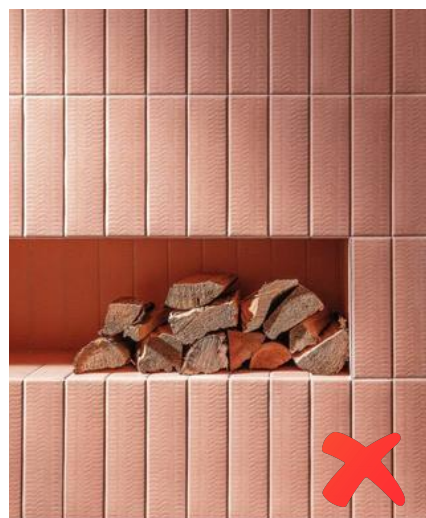
Imagen 16: No se recomienda aplicar revestimiento cerámico en la parte interna del asador tradicional y chimenea de leña.
