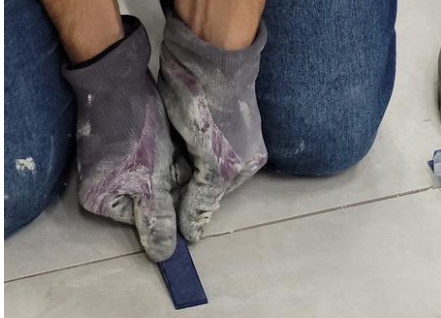
Imagen 35: Inserte la cuña en el clip de forma manual.
