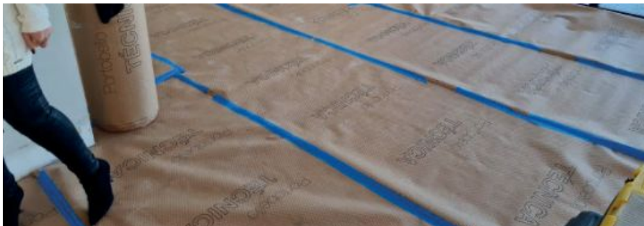
Imagem 46: Protetor de piso aplicado
