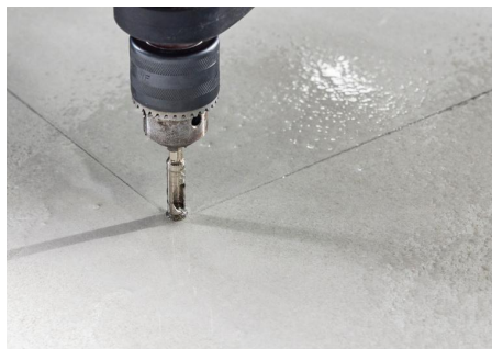
Imagem 80: Furação com serra copo em cada intersecção de 90°.
