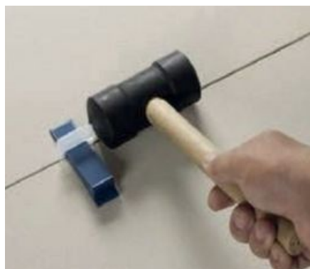
Imagen 44: Retirada del clip y cuña.
