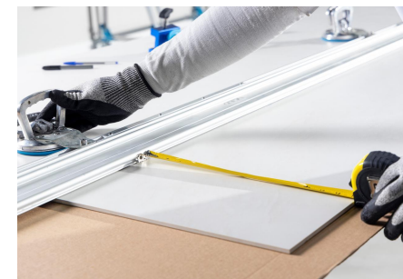
Imagem 59: Marcação do encaixe do trilho.
