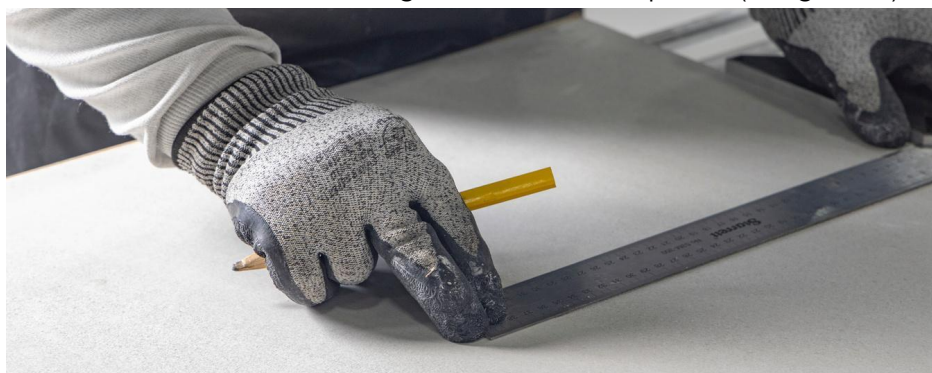
Imagen 84: Dibuje en la pieza el corte que se va a realizar.
