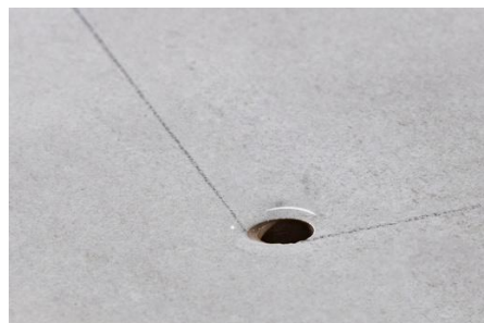
Imagen 86: Finalice la apertura de los cuatro círculos con la sierra de porcelanato.
