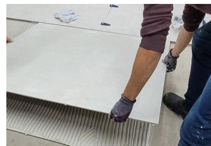
Imagen 33: Ejecución del arrastre en la pieza.
