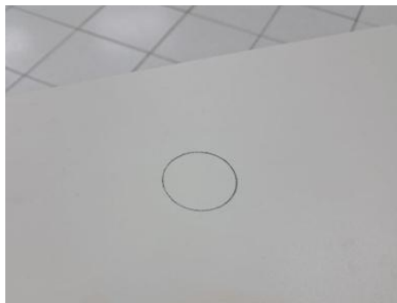
Imagem 89: Marcação do corte circular.
