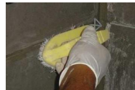
Imagem 34: Limpar com escova o excedente de argamassa das juntas.
