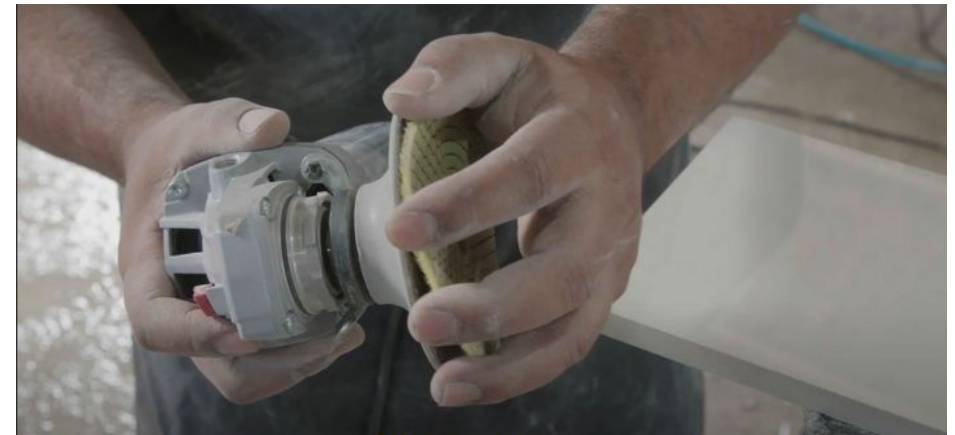
Imagen 102: Acoplamiento del disco cerámico en la amoladora.
