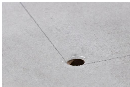
Imagem 86: Finalize a abertura dos quatro círculos com a serra mármore.
