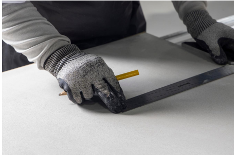
Imagen 52: Marcado de corte en las extremidades.
