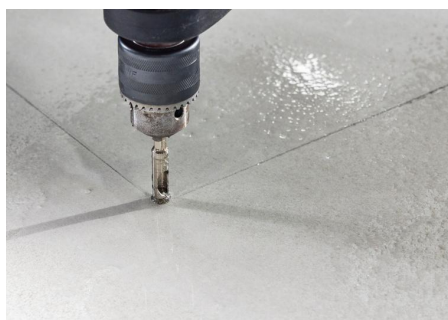
Imagen 80: Perforación con broca de corona en cada intersección de 90°.
