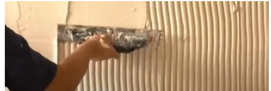
Imagen 28: Apertura de cordones en el revestimiento cerámico con el lado dentado de la llana.
