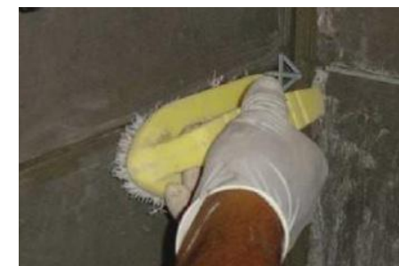
Imagen 34: Limpiar con cepillo el exceso de mortero de las juntas.
