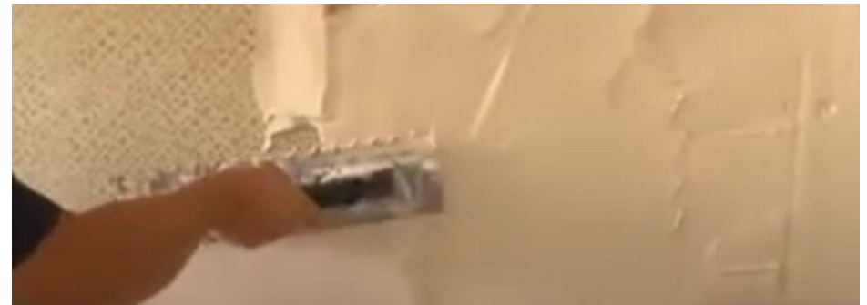
Imagen 27: Aplicación de mortero en el revestimiento cerámico con el lado liso de la llana.
