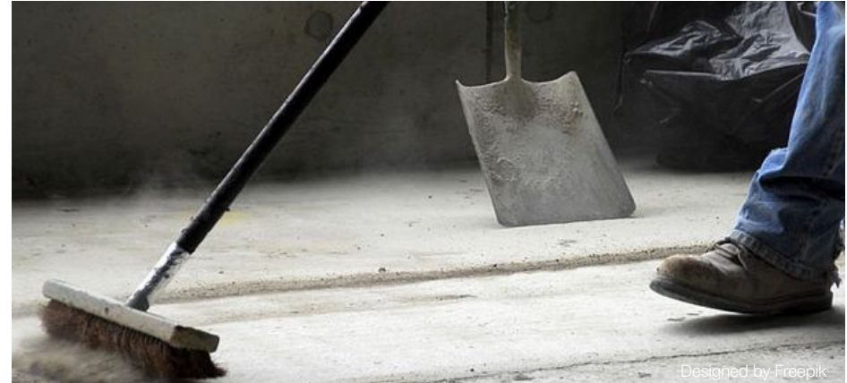
Imagen 22: Limpieza de la base que recibirá el revestimiento cerámico.
