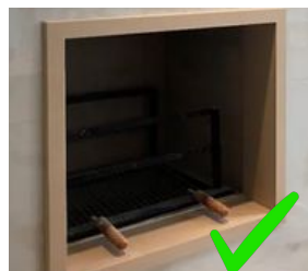
Imagem 11: É aconselhado a utilização de revestimento cerâmico na boca e moldura de churrasqueira.
