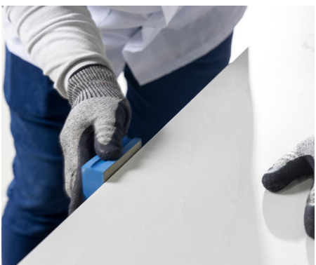
Imagem 100: Utilização da esponja diamantada para acabamento fino.
