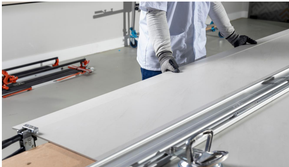
Imagem 66: Ajuste a peça em balanço e posicione os alicates em cada extremidade.
