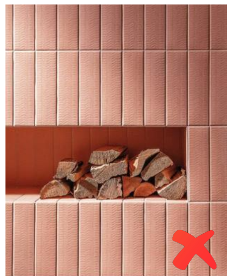
Imagem 16: Não é indicado aplicar revestimento cerâmico na parte interna de churrasqueira tradicional e lareira a lenha.
