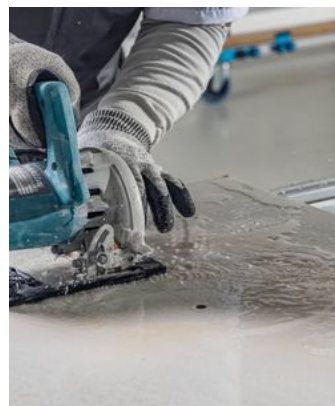
Imagem 87: Finalize a abertura do corte ao encontro do círculo com a serra mármore.
