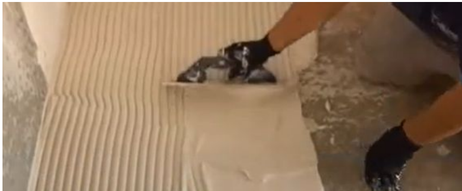
Imagen 26: Apertura de cordones en la base con el lado dentado de la llana.
