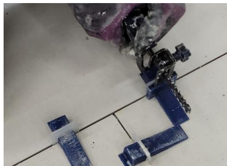
Imagem 36: Execute o aperto com o alicate de pressão.
