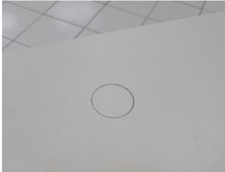
Imagen 89: Marcado del corte circular.
