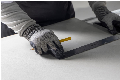
Imagem 52: Marcação de corte nas extremidades.
