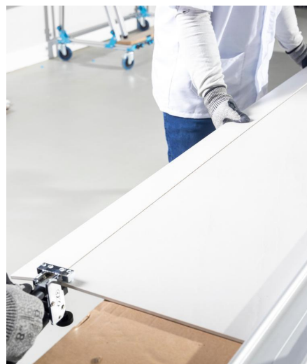
Imagem 68: Na outra extremidade da peça gire a manivela do alicate para a abertura parcial, por fim faça pressão manual no centro da peça.
