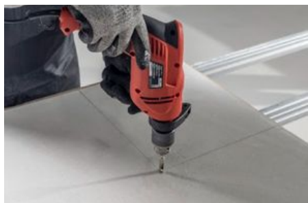
Imagen 85: Finalice la apertura de los cuatro círculos con la sierra de porcelanato.
