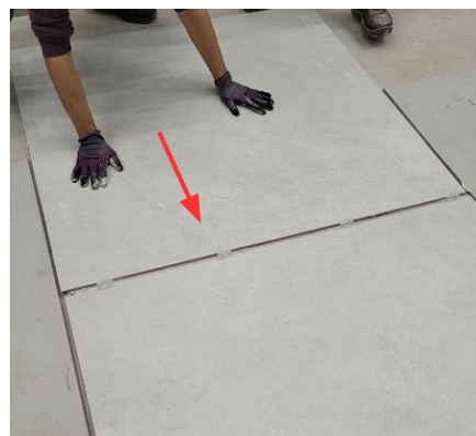
Imagem 30: Execução do arraste na peça.
