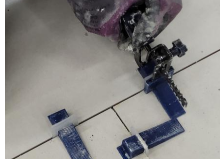
Imagen 36: Realice el ajuste con alicate de presión.
