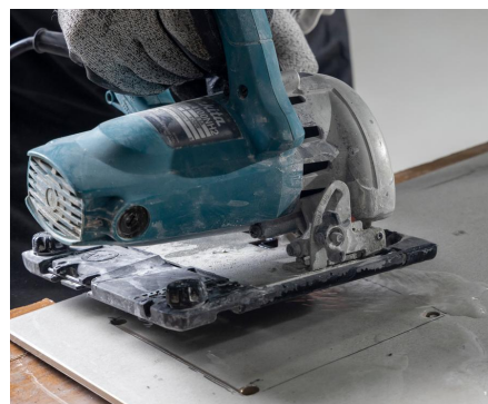
Imagen 82: Finalice la apertura de los cuatro círculos con la sierra de porcelanato.
