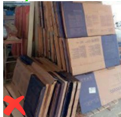
Imagem 04: Empilhamento inadequado.
