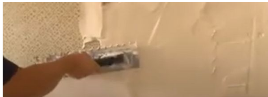
Imagem 27: Aplicação de argamassa no revestimento cerâmico com lado liso da desempenadeira.
