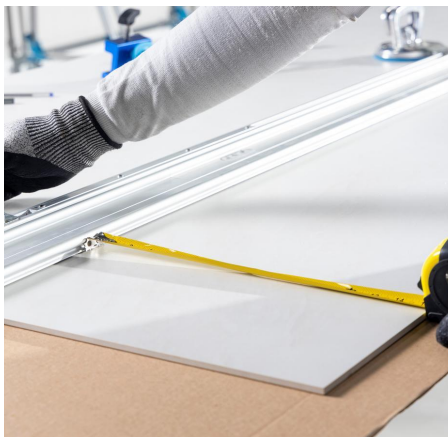
Imagen 70: Marcado del encaje del riel.
