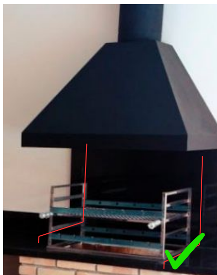
Imagem 15: Revestimento cerâmico em churrasqueira braseiro com as indicações de emenda.
