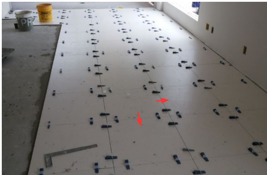
Imagen 42: Las cuñas de una misma hilera deben insertarse en la misma dirección.
