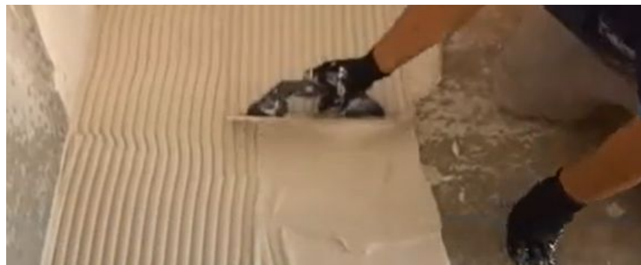
Imagem 26: Abertura de cordões na base com lado dentado da desempenadeira.
