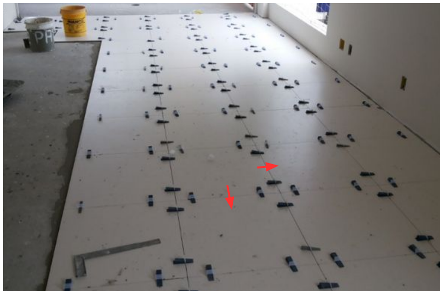
Imagem 42: As cunhas de uma mesma fiada devem ser inseridas no mesmo sentido.
