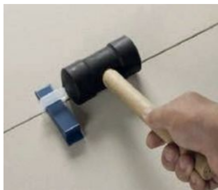
Imagen 44: Retirada del clip y cuña.
