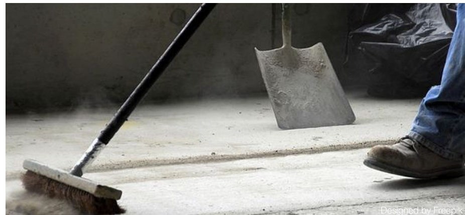
Imagen 22: Limpieza de la base que recibirá el revestimiento cerámico.
