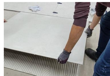
Imagem 33: Execução do arraste na peça.
