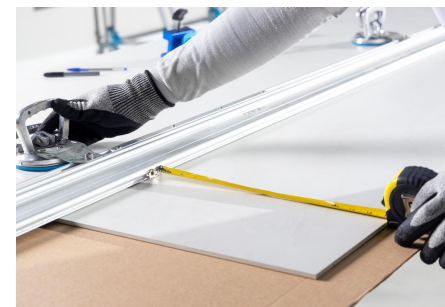
Imagem 59: Marcação do encaixe do trilho.
