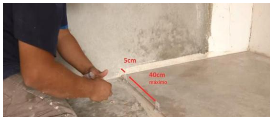
Imagem 41: Os padrões de distanciamento dos clips na peça.
