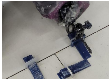
Imagen 36: Realice el ajuste con alicate de presión.
