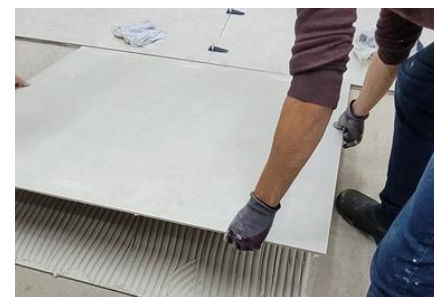
Imagen 33: Ejecución del arrastre en la pieza.
