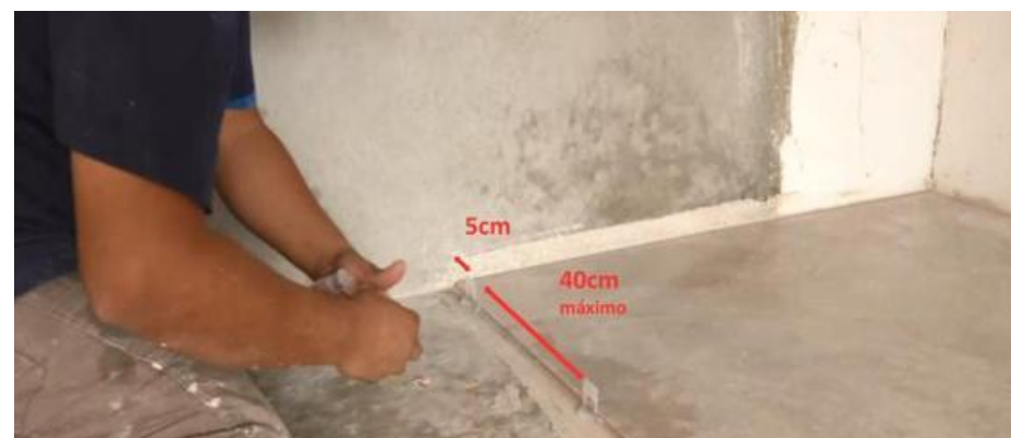
Imagen 41: Los patrones de distancia de los clips en la pieza.
