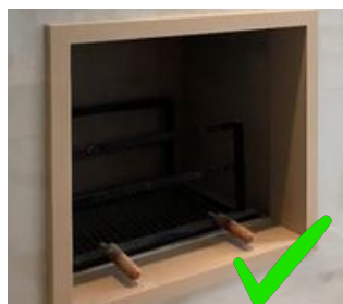
Imagen 11: Se recomienda el uso de revestimiento cerámico en la boca y en el marco del asador.
