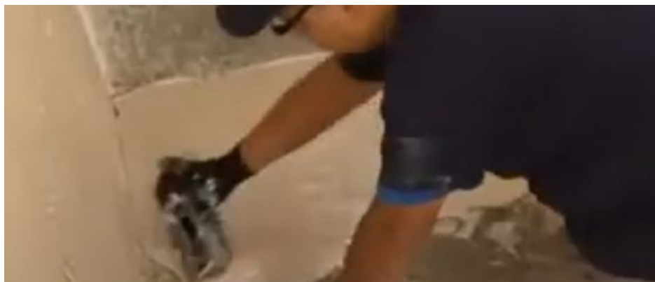
Imagem 25: Aplicação de argamassa na base com lado liso da desempenadeira.
