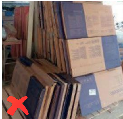
Imagen 04: Apilamiento inadecuado.
