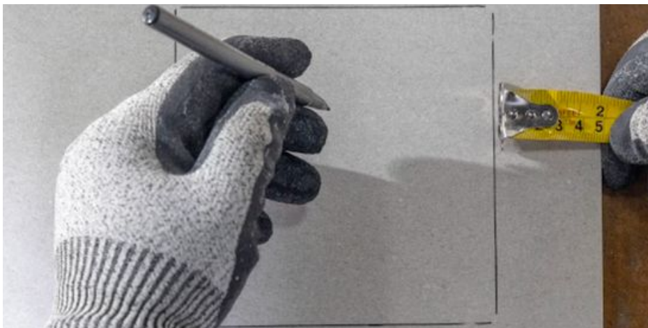
Imagen 79: Dibuje en la pieza el corte que se va a realizar.
