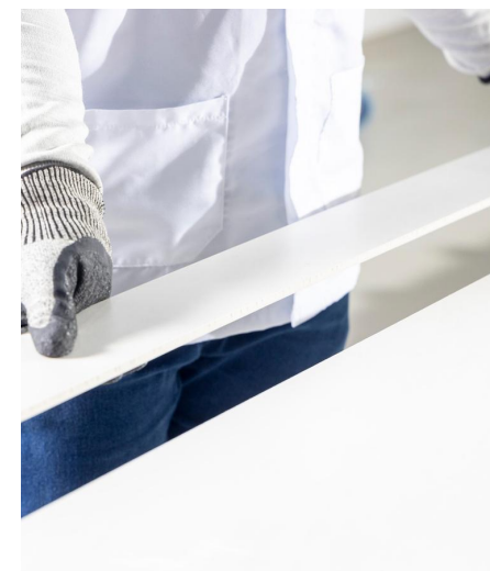
Imagen 69: Luego de ejercer presión en el centro de la pieza, la marca se rompe por completo.
