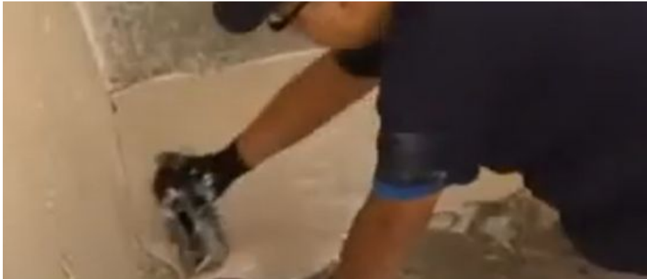
Imagen 25: Aplicación de mortero en la base con el lado liso de la llana.
