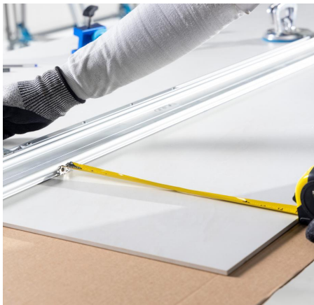
Imagem 70: Marcação do encaixe do trilho.
