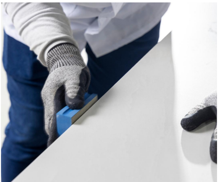
Imagen 100: Uso de la esponja diamantada para acabado fino.
