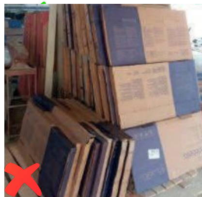
Imagem 04: Empilhamento inadequado.
