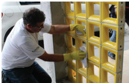
Foto 27: limpeza dos cobogós com pano úmido antes do rejuntamento
