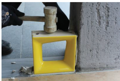
Foto 13: Percussão da placa com martelo de borracha para nivelamento da peça
