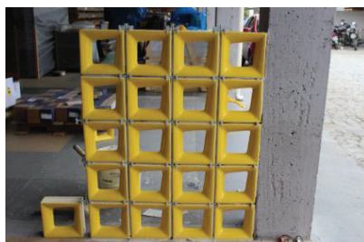
Foto 22: Painel finalizado, aguardando a secagem da argamassa colante para rejuntamento
