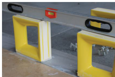
Foto 14: Verificação do nível após assentamento da última peça da fiada para esticar a linha de nylon
