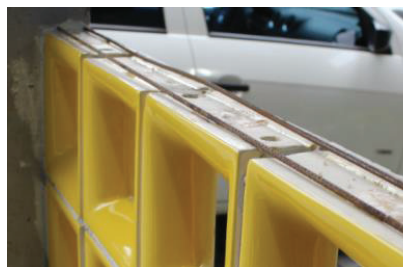
Foto 19: Uso de ferro de 5mm horizontalmente para reforço
