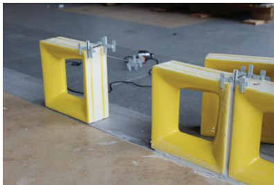
Foto 15: Assentamento dos cobogós após a última peça assentada e linha de nylon esticada
