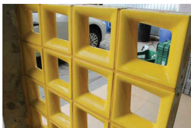
Foto 33: Finalização da limpeza do painel
