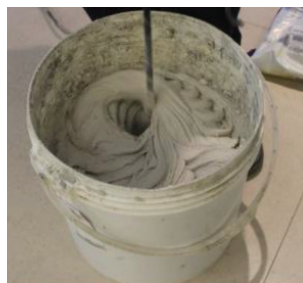
Foto 09: Mistura com haste helicoidal, formando uma pasta homogênea
