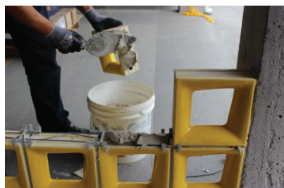
Foto 21: Treliça inserida na junta de assentamento
