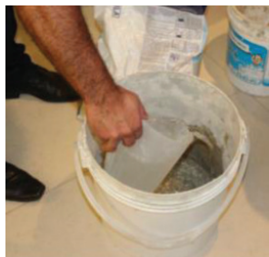
Foto 07: Preparo da argamassa colante – adição da água
