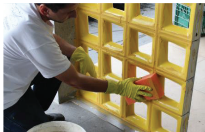
Foto 31: Remoção do excesso do rejunte com esponja e água limpa
