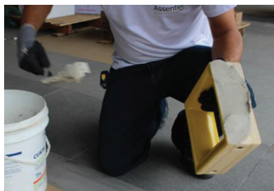
Foto 10: Aplicação argamassa colante nas laterais do Cobogó
