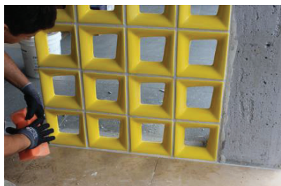
Foto 32: Finalização da limpeza do painel
