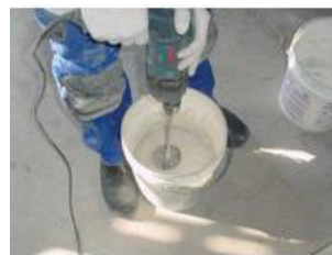
Foto 25: Mistura com a haste helicoidal
