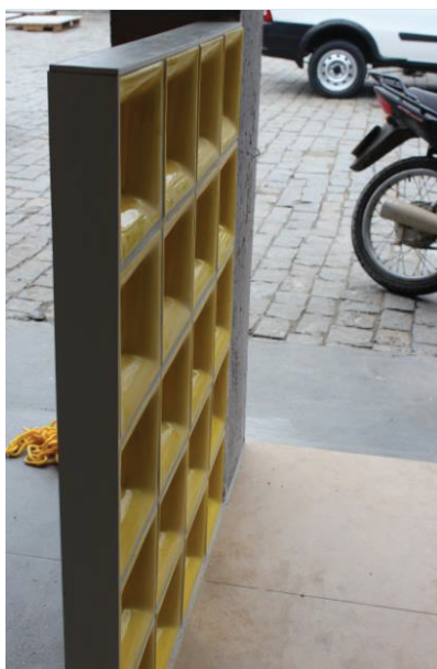
Foto 34: Acabamento lateral e superior feito em madeira
