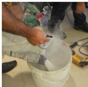
Foto 08: Preparo da argamassa colante – adição do pó
