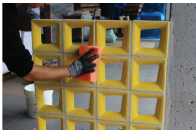
Foto 30: Remoção do excesso de argamassa com esponja e água limpa
