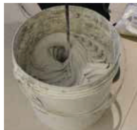
Foto 13: Mistura com haste helicoidal, formando uma pasta homogênea
