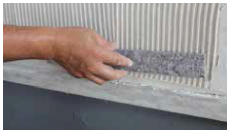
Foto 17: Posicionamento da peça cerca de 3cm da localização final
