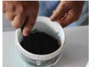
Foto 27: Mistura da argamassa de rejunte
