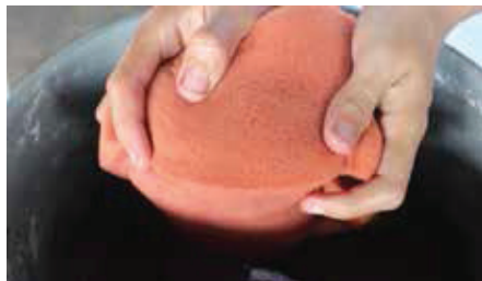
Foto 31: Lavação da esponja para limpeza do rejunte
