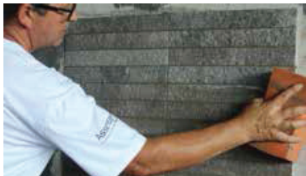
Foto 30: Limpeza do rejunte com esponja úmida
