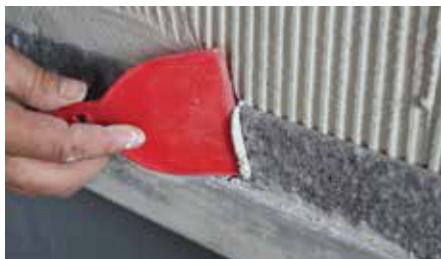
Foto 22: Remoção do excesso de argamassa com espátula de plástico
