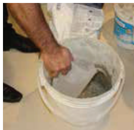
Foto 11: Preparo da argamassa colante – adição da água
