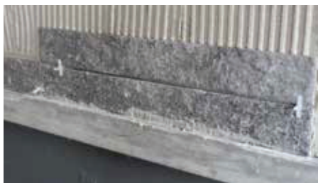
Foto 23: Espaçadores de 2mm formando as juntas de assentamento
