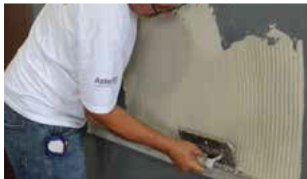
Foto 16: Formação dos cordões com desempenadeira dentada de 8mm
