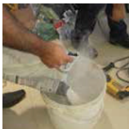
Foto 12: Preparo da argamassa colante – adição do pó
