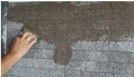
Foto 28: Aplicação do rejunte com desempenadeira de borracha
