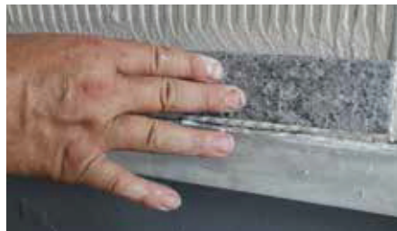
Foto 18 : Peça arrastada até a posição final, esmagando os cordões de argamassa colante
