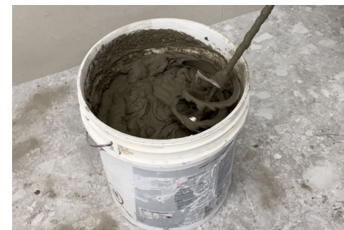
Foto 5: Mistura com haste helicoidal, formando uma pasta homogênea.
