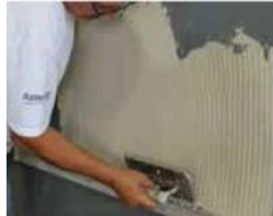
Foto 06: Aplicação de argamassa colante na base de assentamento
