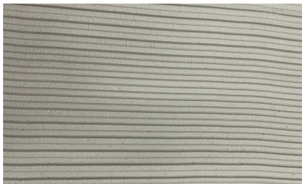
Foto 08: Cordões regulares de argamassa colante
