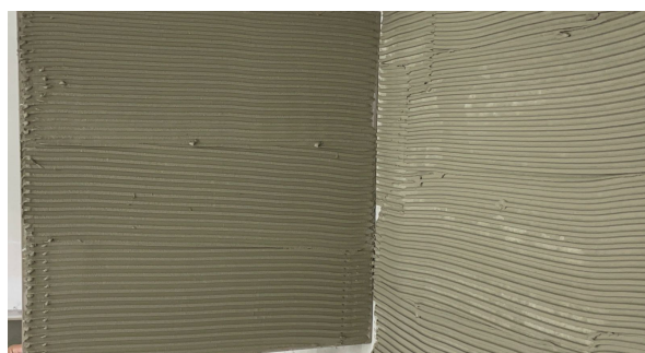
Foto 09: Dupla colagem: cordões no sentido paralelo (mesmo sentido)
