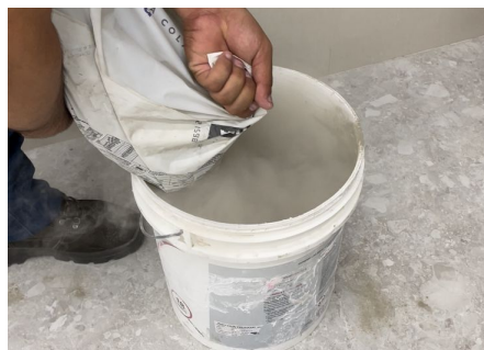
Foto 4: Preparo da argamassa colante | adição do pó.
