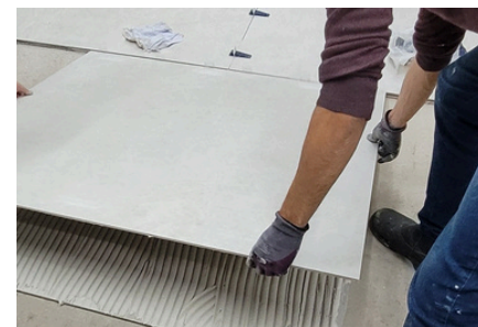
Imagen 33: Ejecución del arrastre en la pieza.
