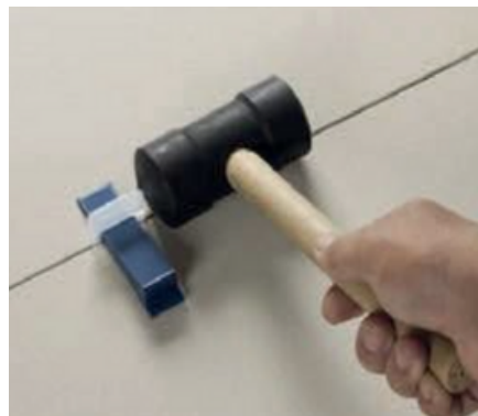
Imagen 44: Retirada del clip y cuña.
