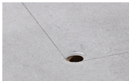
Imagen 86: Finalice la apertura de los cuatro círculos con la sierra de porcelanato.
