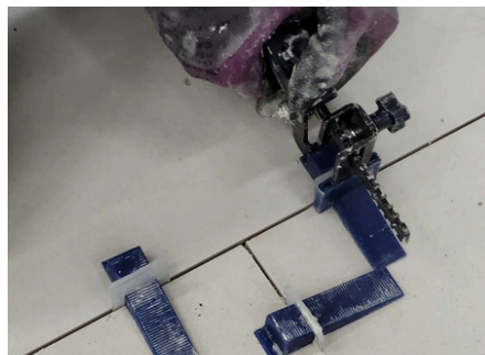
Imagen 36: Realice el ajuste con alicate de presión.
