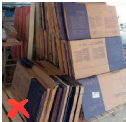
Imagem 04: Empilhamento inadequado.
