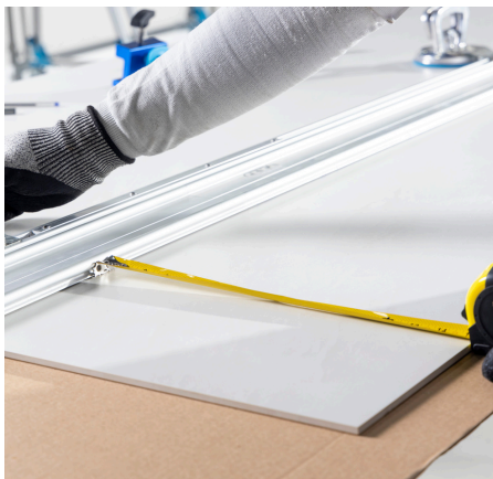
Imagem 70: Marcação do encaixe do trilho.
