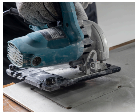
Imagem 82: Finalize a abertura dos quatro círculos com a serra mármore.
