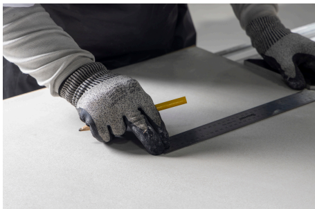
Imagen 52: Marcado de corte en las extremidades.
