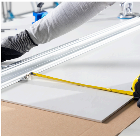
Imagen 70: Marcado del encaje del riel.
