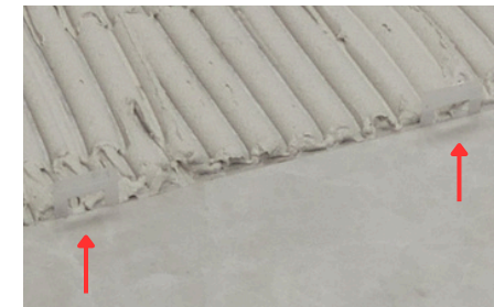
Imagen 32: Espaciador del tipo nivelador.
