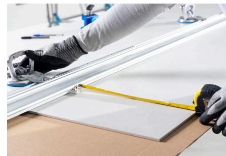
Imagen 59: Marcado del encaje del riel.
