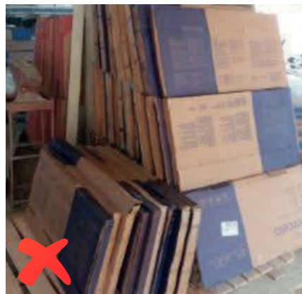
Imagen 04: Apilamiento inadecuado.
