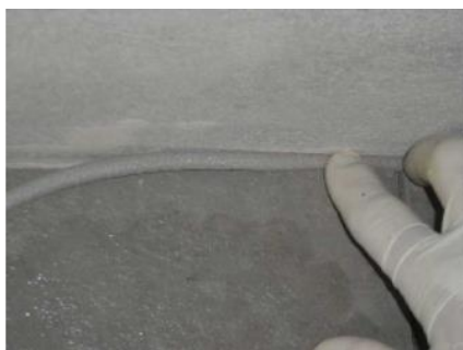
Inserção do limitador de fundo de viga
