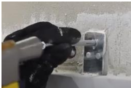
Fixação da bucha prego com martelo
