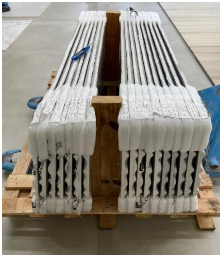
Armazenamento das peças na vertical com o maior lado apoiado sobre estrado de madeira
