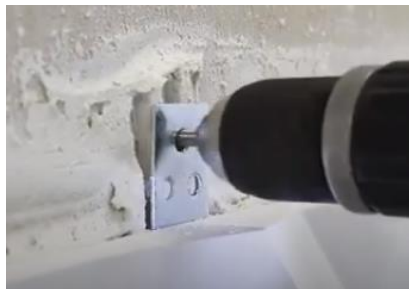
Perfuração do emboço
