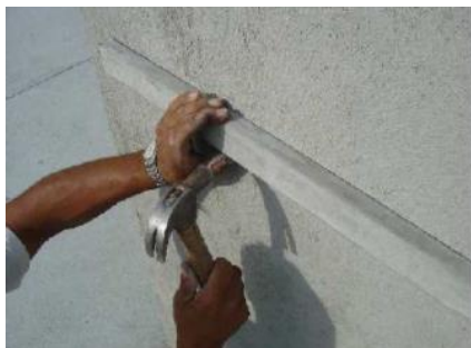
Fixação da régua metálica
