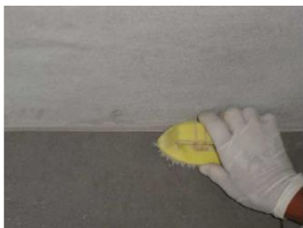
Limpeza da junta de dessolidarização
