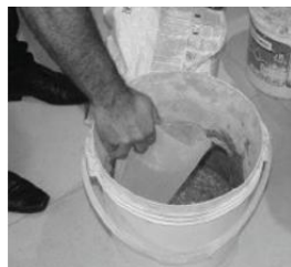
Preparo da argamassa colante – adição da água
