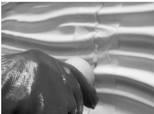
Aplicação do rejunte com bisnaga
