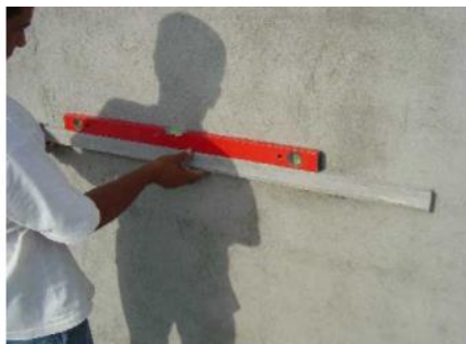
Conferência do nível da régua metálica
