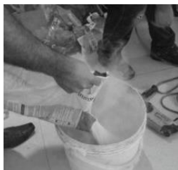
Preparo da argamassa colante – adição do pó
