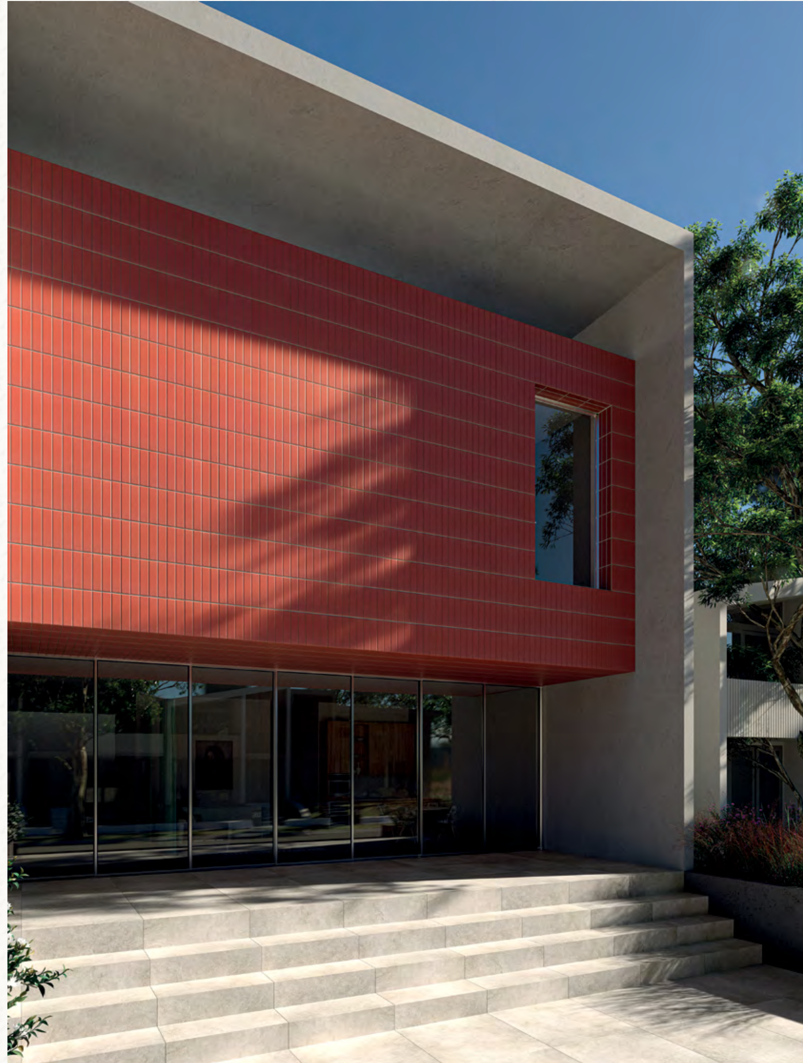
Terralma Arizona Berliner Zement
