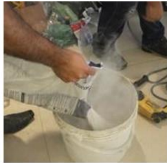
Preparo da argamassa colante – adição do pó
