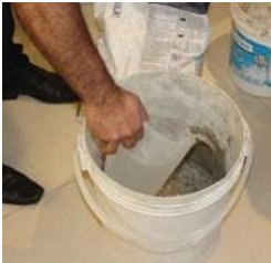
Preparo da argamassa colante – adição da água
